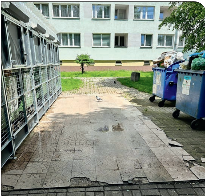
os. Jasne 18-19 teren przy śmietniku przed wymianą nawierzchni
