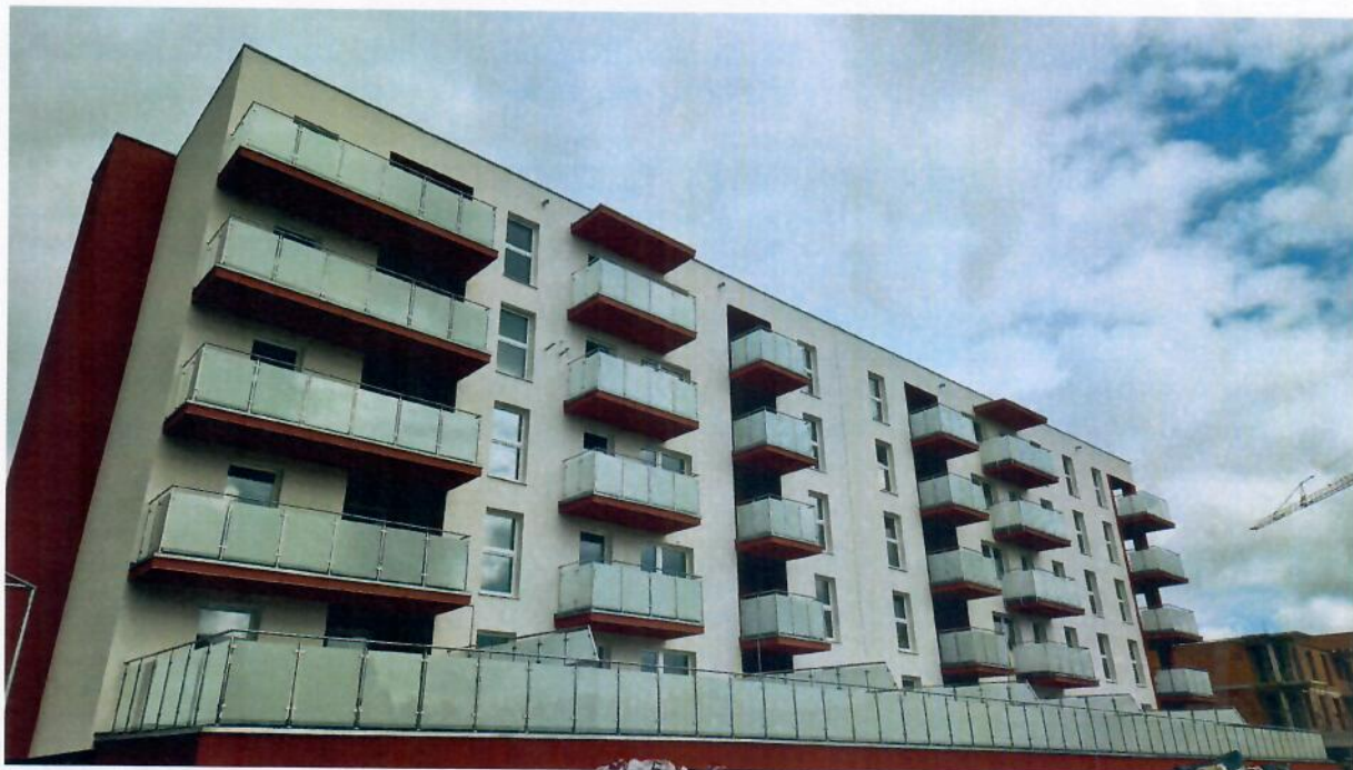
Zakończona budowa przy ul. Korczaka 21 w Dzierżoniowie
