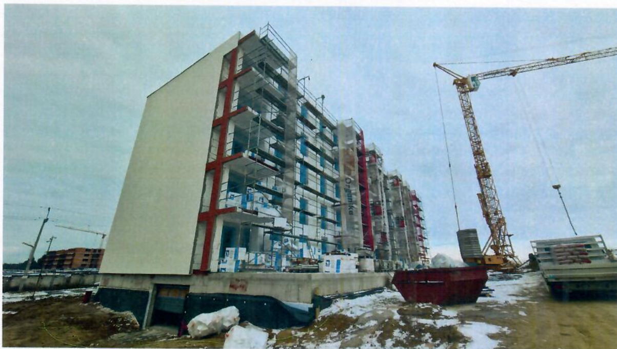
Kontynuowana budowa przy ul. Korczaka 19 w Dzierżoniowie
