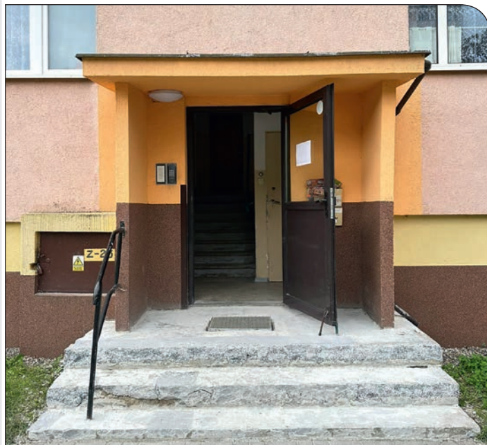
os. Jasne 1E - schody w trakcie remontu
